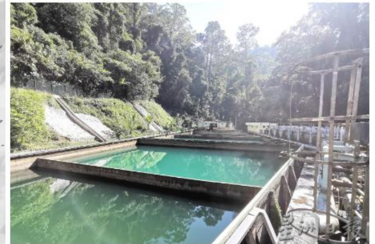
虽然班底滤水站部分结构也遭遇土崩，但经过抢修后，依然可以发挥作用。
